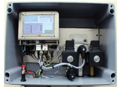
Bu kutu; daha doğrusu iç dünyası – o ticari araçlar için olan büyük otomatik lastik hava doldurma tesisini yönetiyor.
